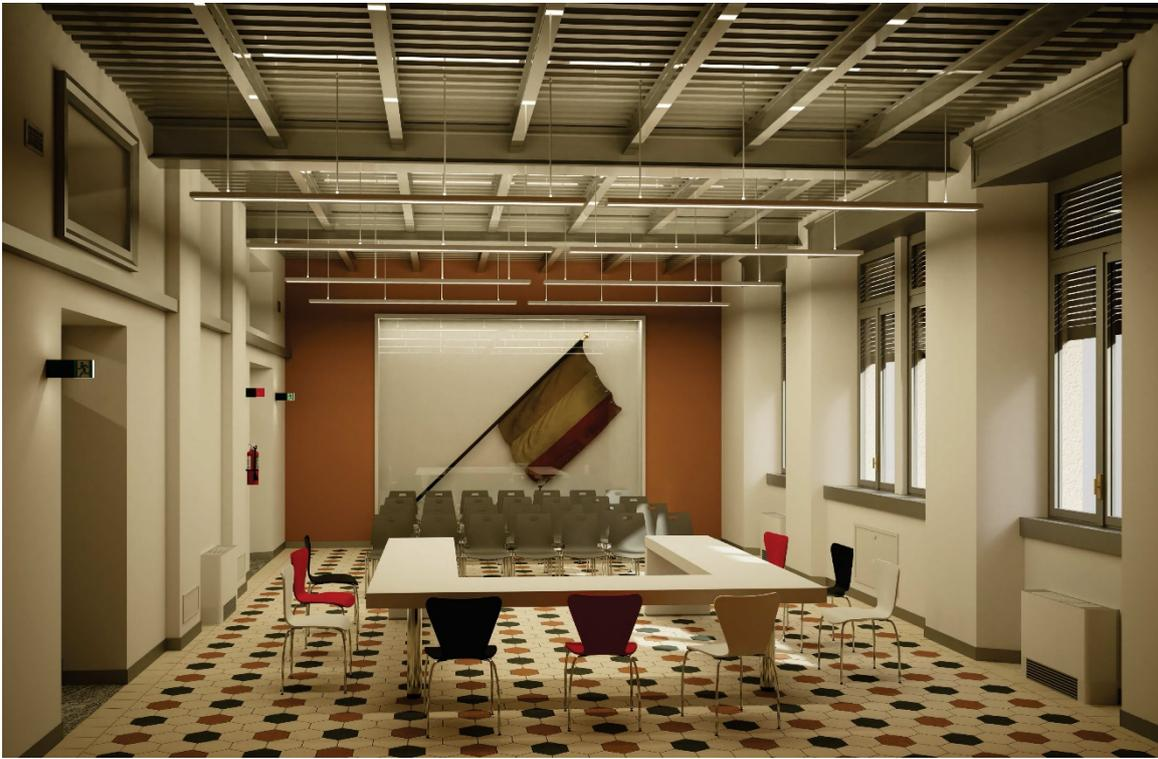
*Le opere* consistono nel consolidamento e risanamento dei muri perimetrali, formazione di intercapedini perimetrali e formazione vespaio per migliorare le condizioni igrometriche degli ambienti seminterrati. Rifacimento dei solai, rispettando le attuali quote di calpestio, con nuove strutture in travi metalliche e lamiera grecata lasciati a vista. Consolidamento dell'orditura in legno della copertura, consolidamento della scala interna e dei maschi murari.
